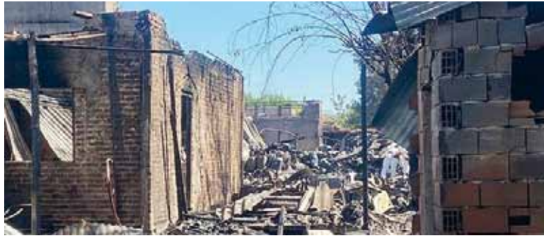
En ruinas. Así quedó el depósito clandestino de garrafas.
